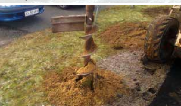
Boring af huller til sikkerhedshegn
